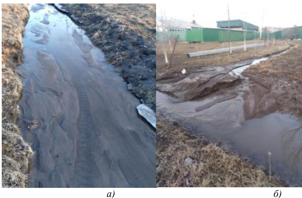
Рисунок 5 – Общая картина эрозии почвы при водоотведении: а- заиливание русел кюветов; б - смыв плодородной фракции почвы
