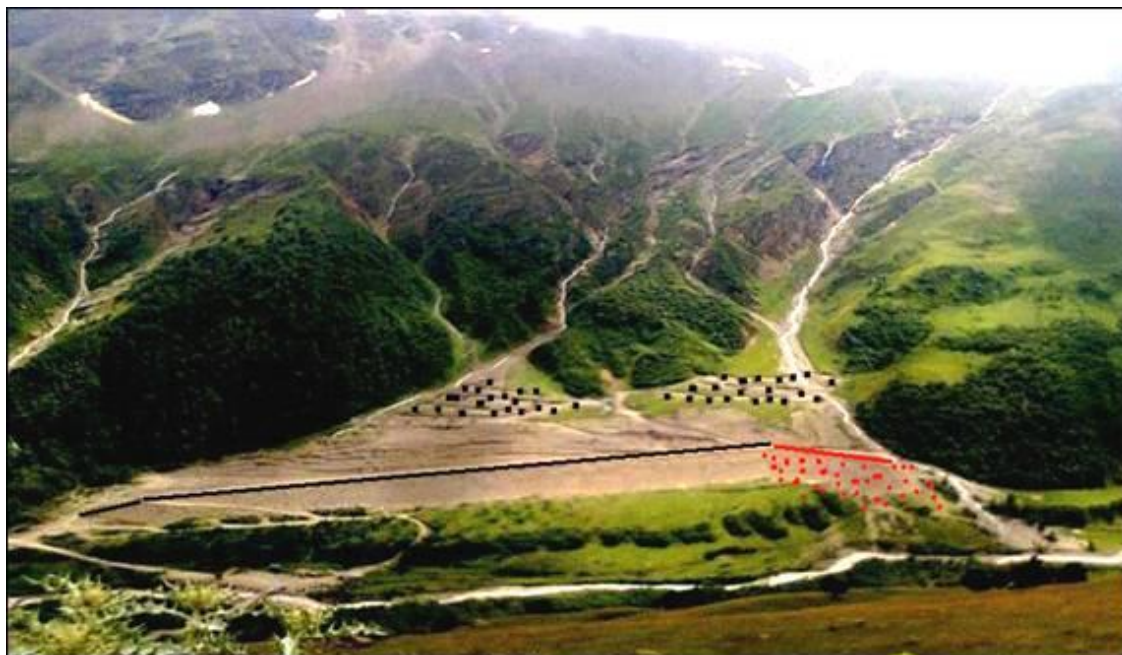
Рис. 4 Прил. Лавинный бассейн с лавиносборами № 62(9) – 61 (10). Комплекс противолавинных сооружений: дамба и клинья (справа налево). Фото Кюль Е. В. Июль 2014 г.
