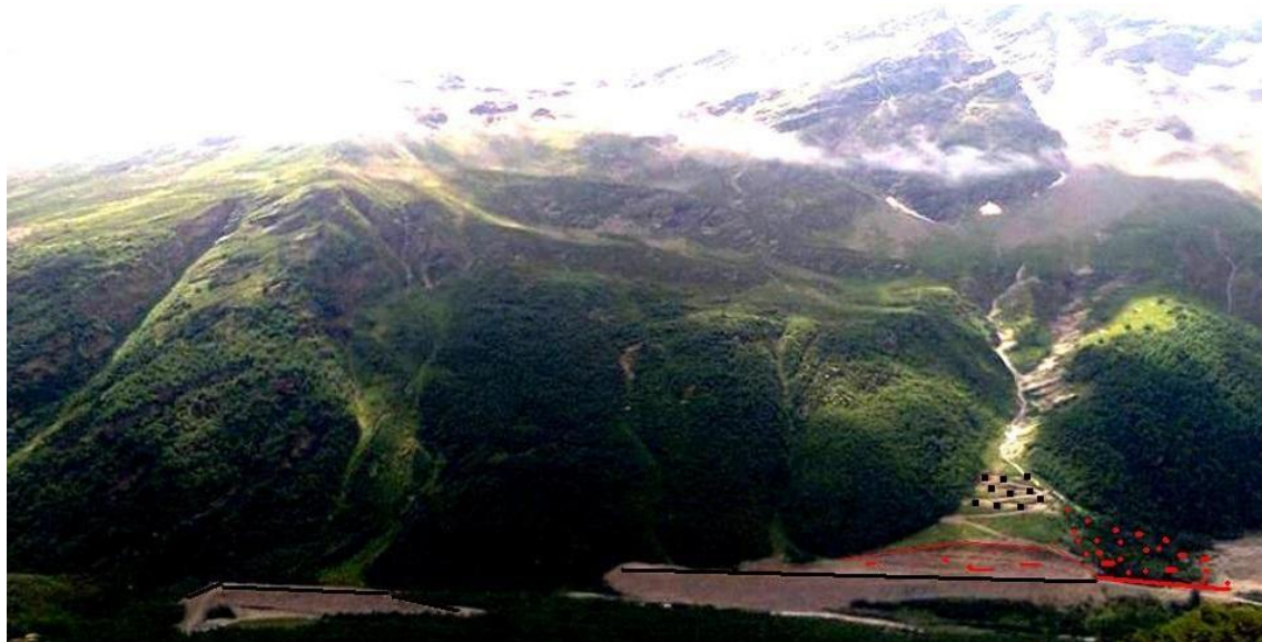
Рис. 5 Прил. Лавинный бассейн с лавиносборами № 61 (11) – 59 (12 – 13). Комплекс противолавинных сооружений (справа налево): дамба и клинья. Сложный лавиносбор № 58 (14).
