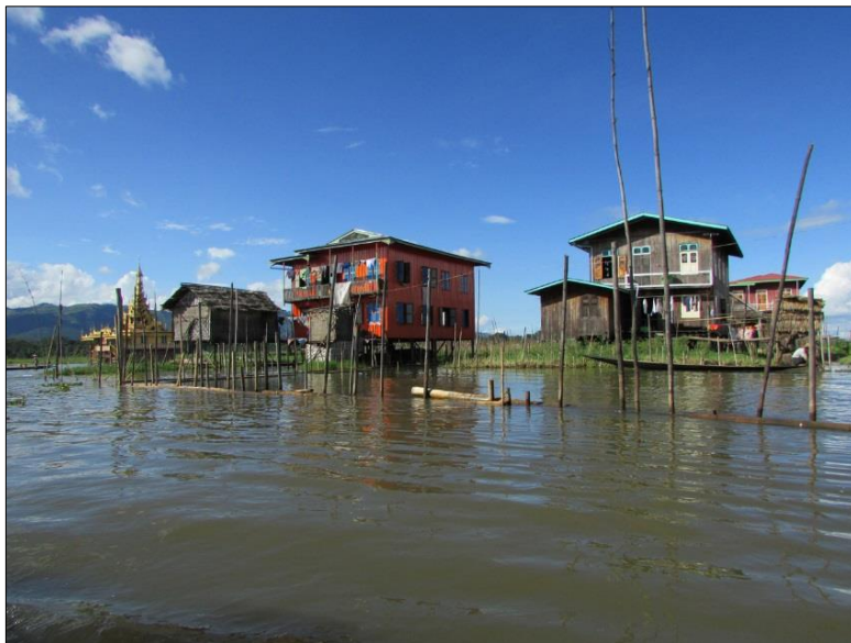
Рис. 2. Типичные дома на сваях, построенные на прибрежных мелководьях оз. Инле. Фото А.Е. Скопина.
